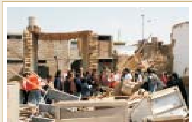
Inspeccionando los daños en la ciudad de Pisco
