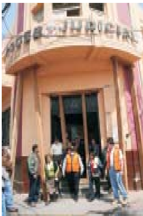
El Juzgado Penal de Chincha sufrió severos daños estructurales.
